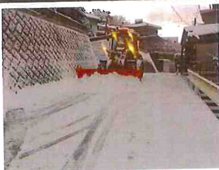
(除雪作業状況)
