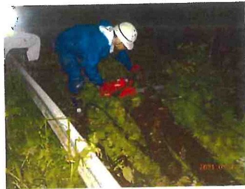
夜間災害出動(豪雨による倒木除去)
