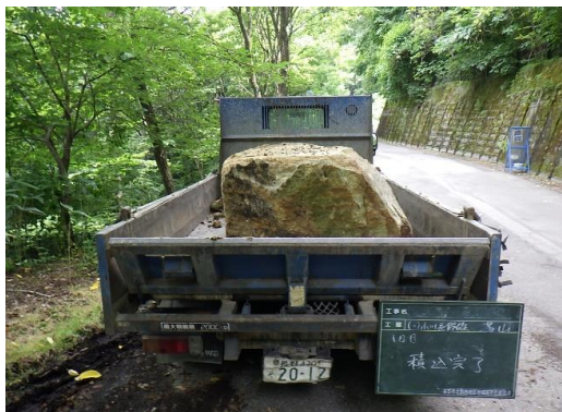
ゲリラ豪雨後の落石撤去
