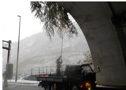
積雪の重みによる倒木撤去
