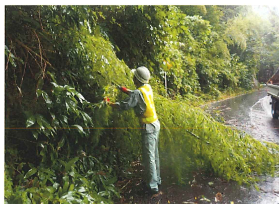
ゲリラ豪雨による倒木の除去作業状況
