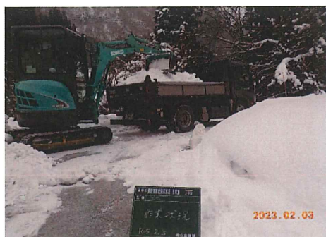
(排雪作業状況)
