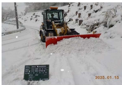
(除雪作業状況)
