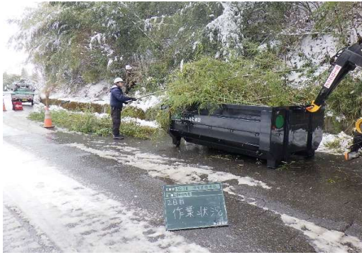
積雪の重みによる倒木撤去
